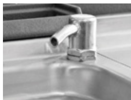
Torneira acoplada para abastecimento de água.
